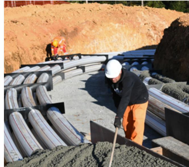
Beispiel einer Verkabelung im Kabelrohrblock
