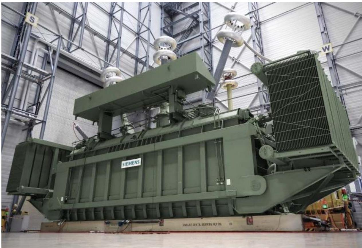
Figure 1-4 : Self triphasée 420 kV, 50-250 Mvar (longueur 18,7 m, largeur de la cuve 4 m, largeur 7,6 m, hauteur de la cuve 4,5 m, hauteur 11,1 m, poids de transport 219 000 kg, poids en service 361 000 kg). Source [1.1]
