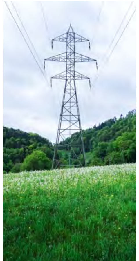
La ligne existante de 145 kilovolts sera entièrement démantelée après la mise en service de la nouvelle ligne de 220 kilovolts.
